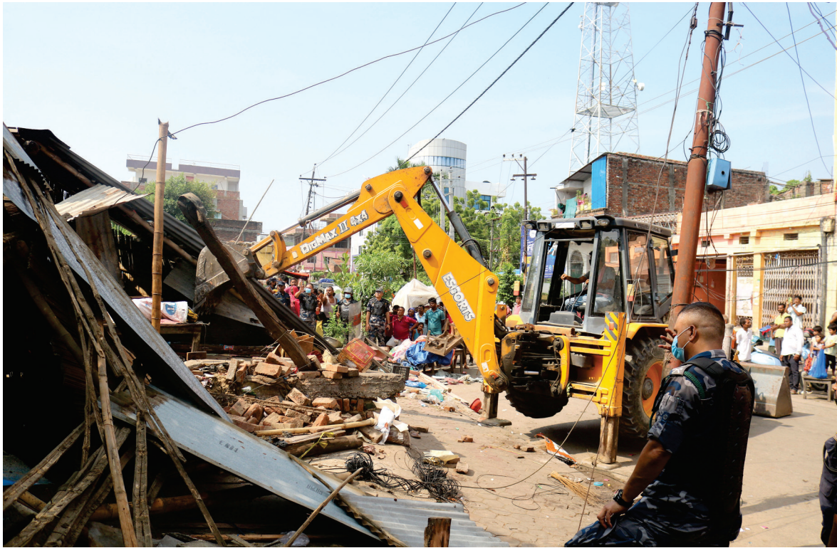
अतिक्रमित संरचना हटाउँदै: जनकपुरधाम उपमहानगरपालिका-६, पेठिया बजार नजिक गोधरेडि पोदरी डिलमा अतिक्रमित गरी निर्माण गरिएको संरचना डोजरको सहायताले हटाउँदै । रासस
