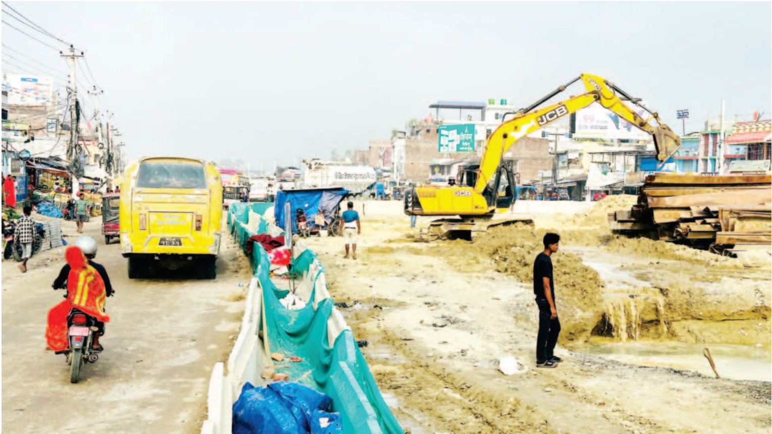
ओभरपास निर्माण: पूर्व-पश्चिम राजमार्ग अन्तर्गत सिरहाको लहान नगरपालिका-१ शहीदचोकमा ओभरपास निर्माण कार्य गरिँदै । वर्षापछि रोकिएको निर्माण कार्य पुनः सञ्चालनमा आएको निर्माण कम्पनीले जनाएको छ । तस्बिर: रासस
