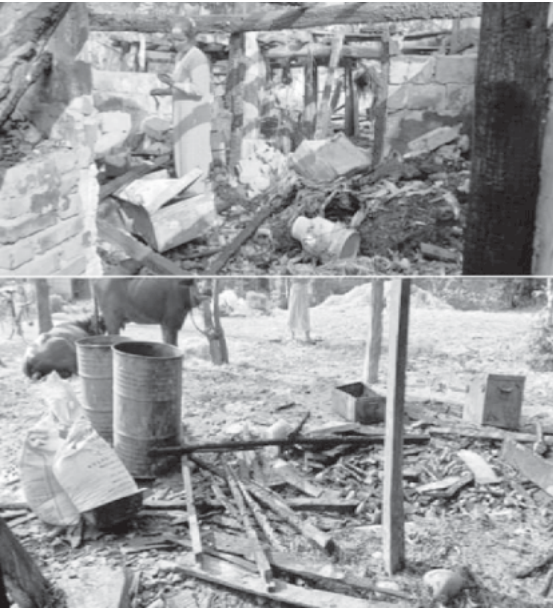
मधेशहटि रीतहट । रीतहटको उतरिभेग चन्द्रपुर नगरपालिका वडा नम्बर ६
